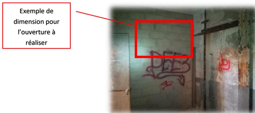
**Figure 7 : Mur intérieur séparant les deux pièces ou une ouverture devra être réalisée**
