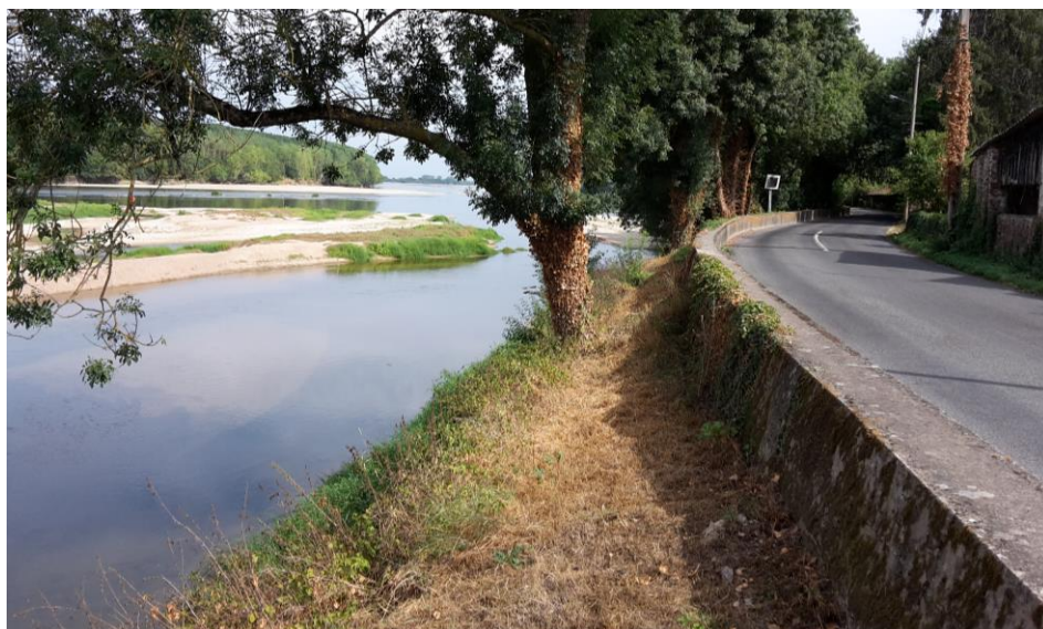
Figure 14: Levée de protection du Val du Petit Louet – commune de Juigné-sur-Loire
