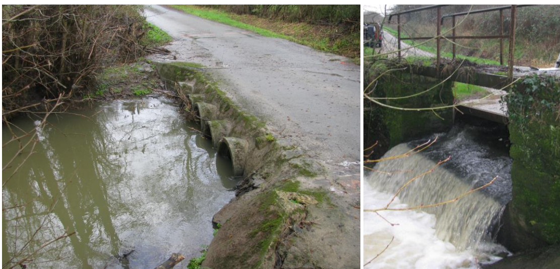
Figure 23 : Buses sur le Javoineau (La Roche Martin, 2014) (à gauche), Seuil sur l'Arcison (2013) (à droite)
