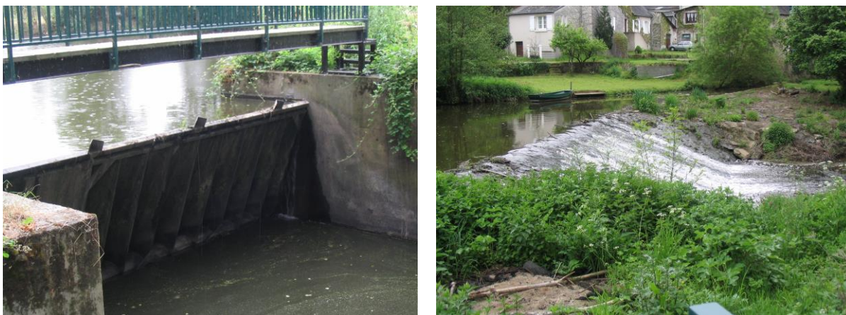
Figure 22 : Clapet position haute (à gauche) et ancienne chaussée de moulin (à droite) (Bézigon, 2013)
