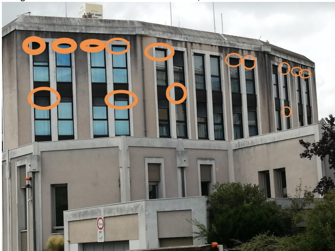
Figure 6 : localisation des sites de nidification, bâtiment Jeanneteau-face Est
