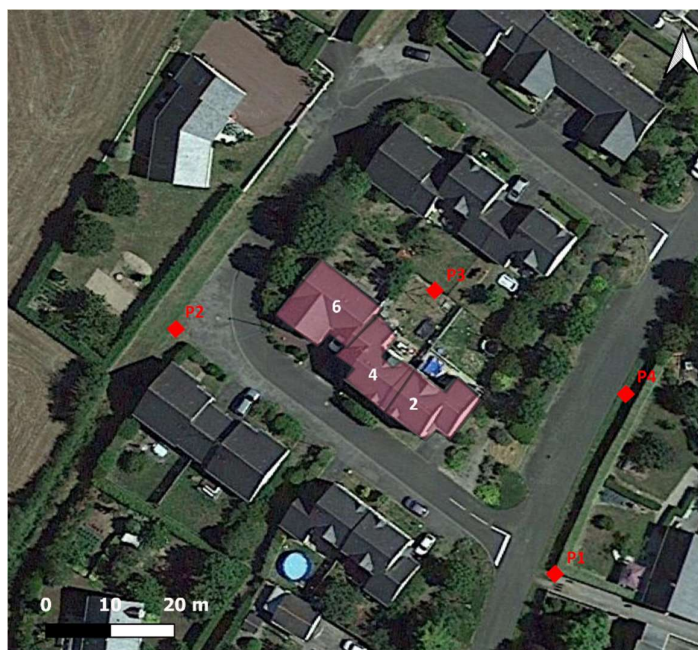
Figure 2 : Points d'observation effectivement réalisés sur le terrain pour les 2-4-6 rue de la Paternelle
