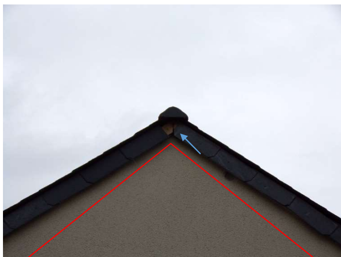
Figure 18 : Emplacement du nichoir sur la façade
