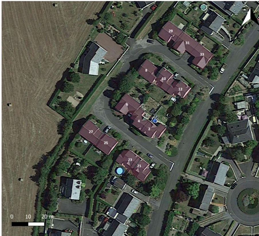
Figure 1 : Photographie satellite du site de l'opération 877
