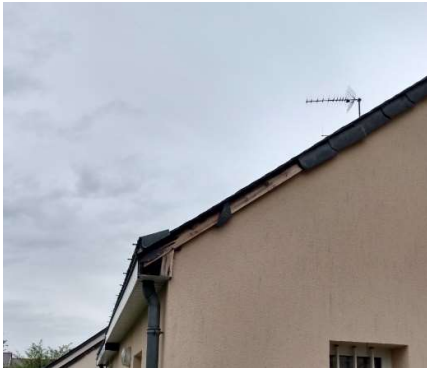
Figure 8 : Exemple d'accès aux espaces sous-toiture et au cache-moineaux
