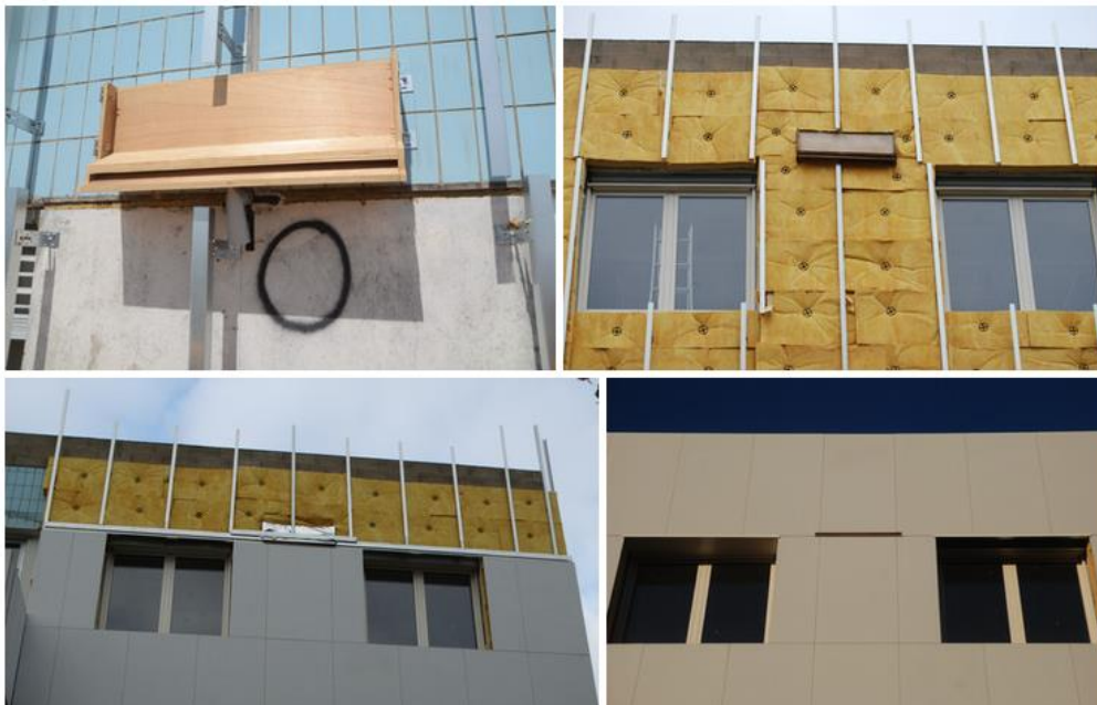
Installation d'un gîte qui sera intégré dans l'isolation extérieure d'un bâtiment (clichés : Muséum de Bourges)
