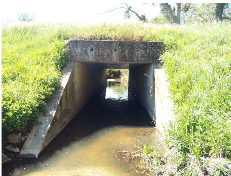
Vue amont de l'ouvrage
