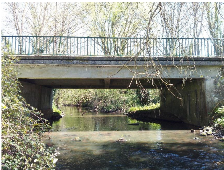
Vue aval de l'ouvrage
