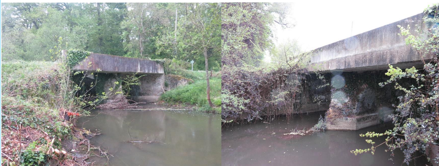
Vue aval de l'ouvrage
