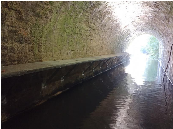
FIGURE 9 : PASSAGE A FAUNE SOUS LA RD 323 EFFECTUEE PAR LE CD 49 EN 2021.
