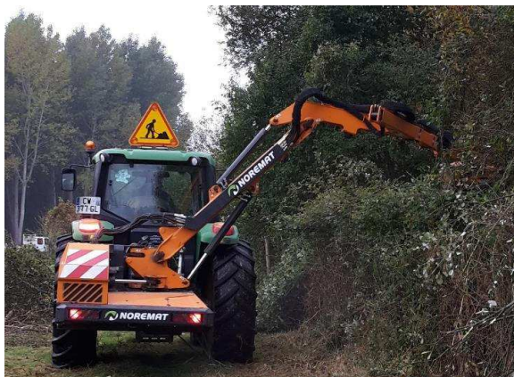
Figure 41 : Intervention d'un engin permettant de dégager la ripisylve, voire de réaliser des trouées.
