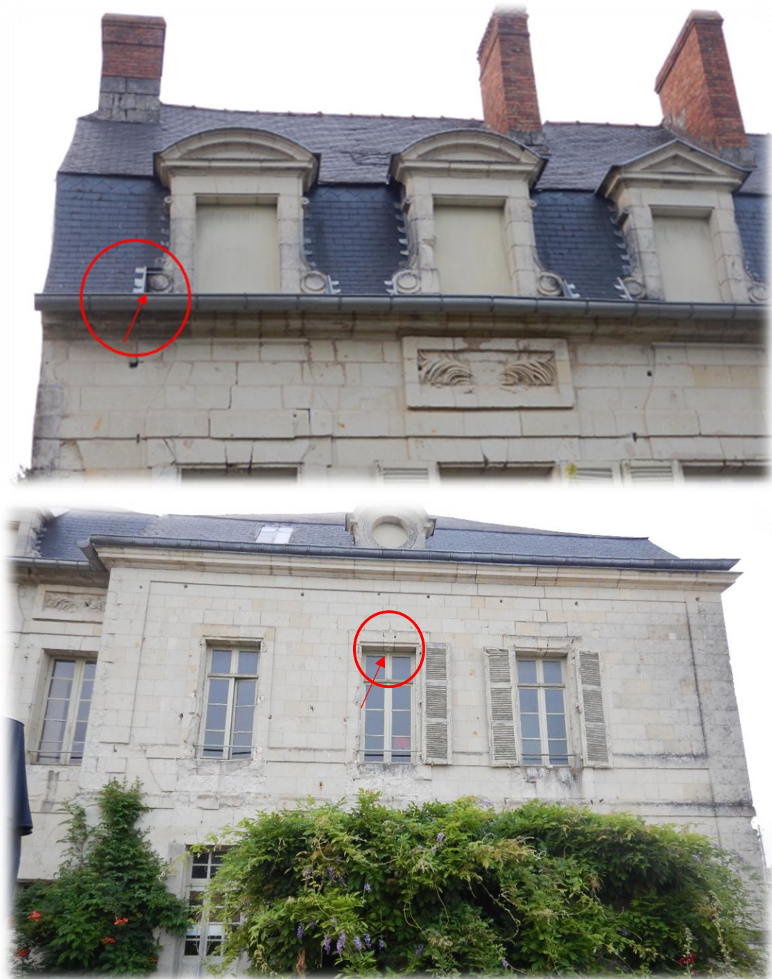
Figure 11 : Illustration des sorties de gîtes observées sur la façade sud du bâtiment
