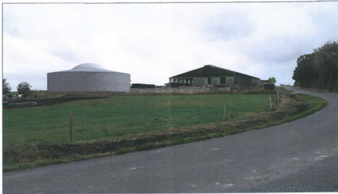
Digesteur et fosse de stockage du digestat liquide
