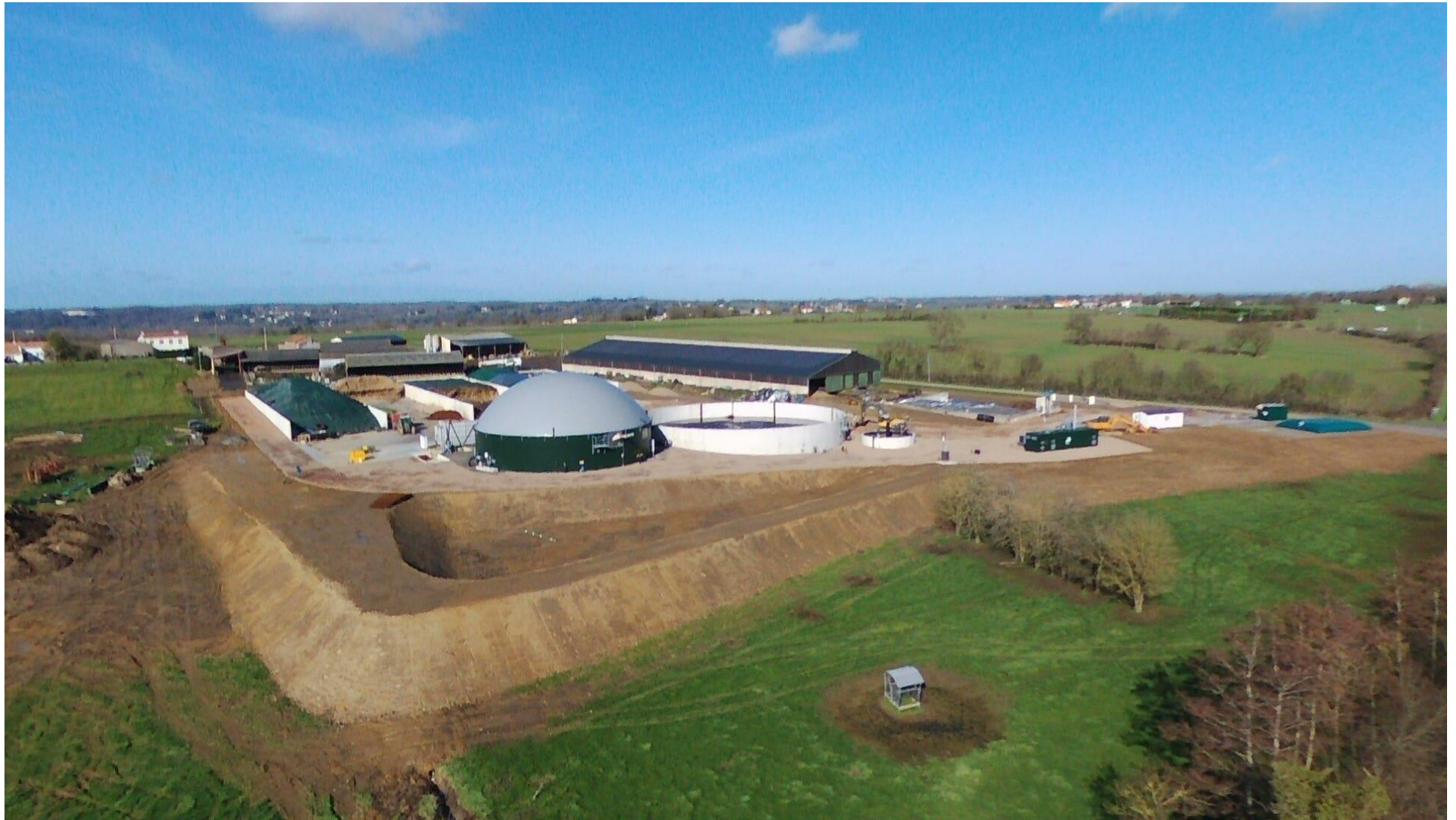
Site actuel en vue aérienne
