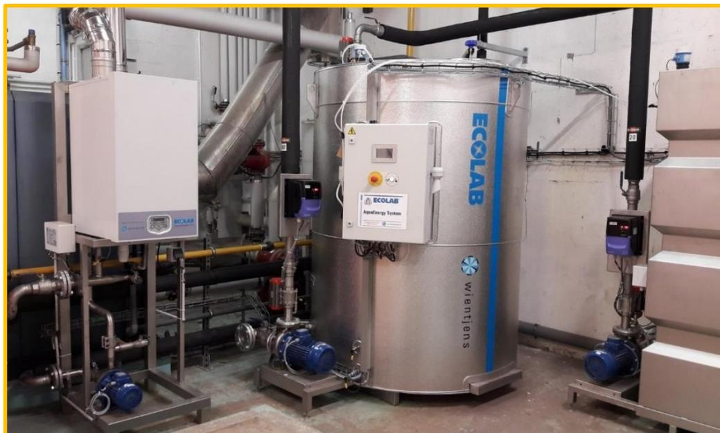
Figure 2 : Exemple AQUAHEATER (Source ECOLAB)
