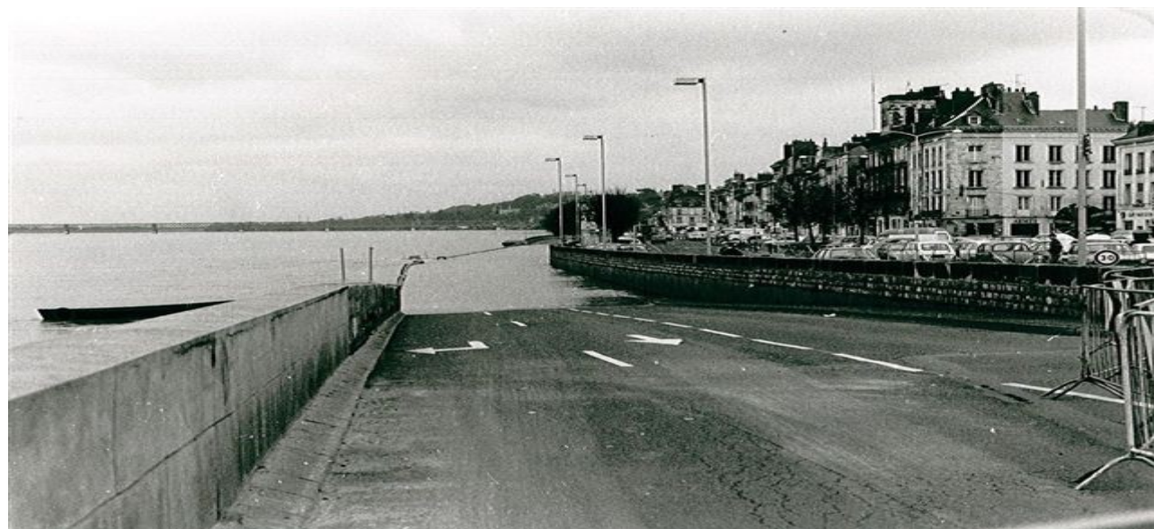
1982, Inondations à Saumur provoquant la fermeture de la RD 947 (photo DDT49)
