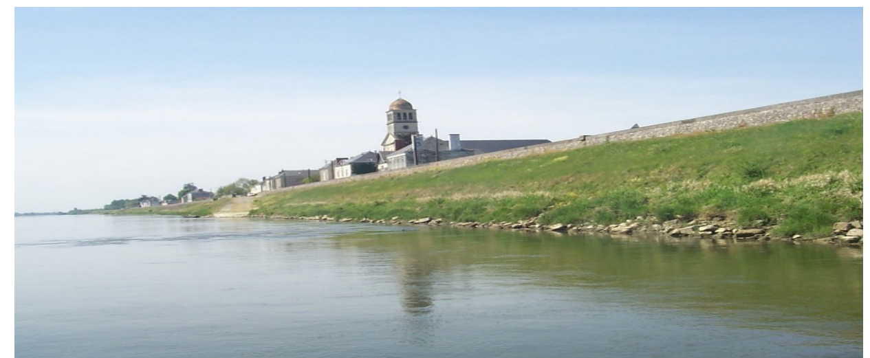
Levée de l'Authion à la Bohalle (photo DDE 49)
