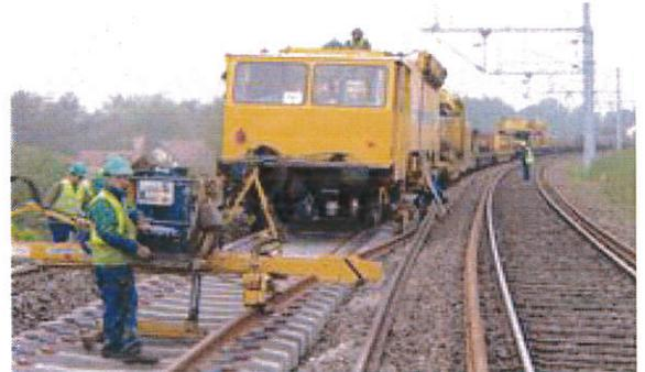
Longs Rails soudés sur traverses béton
