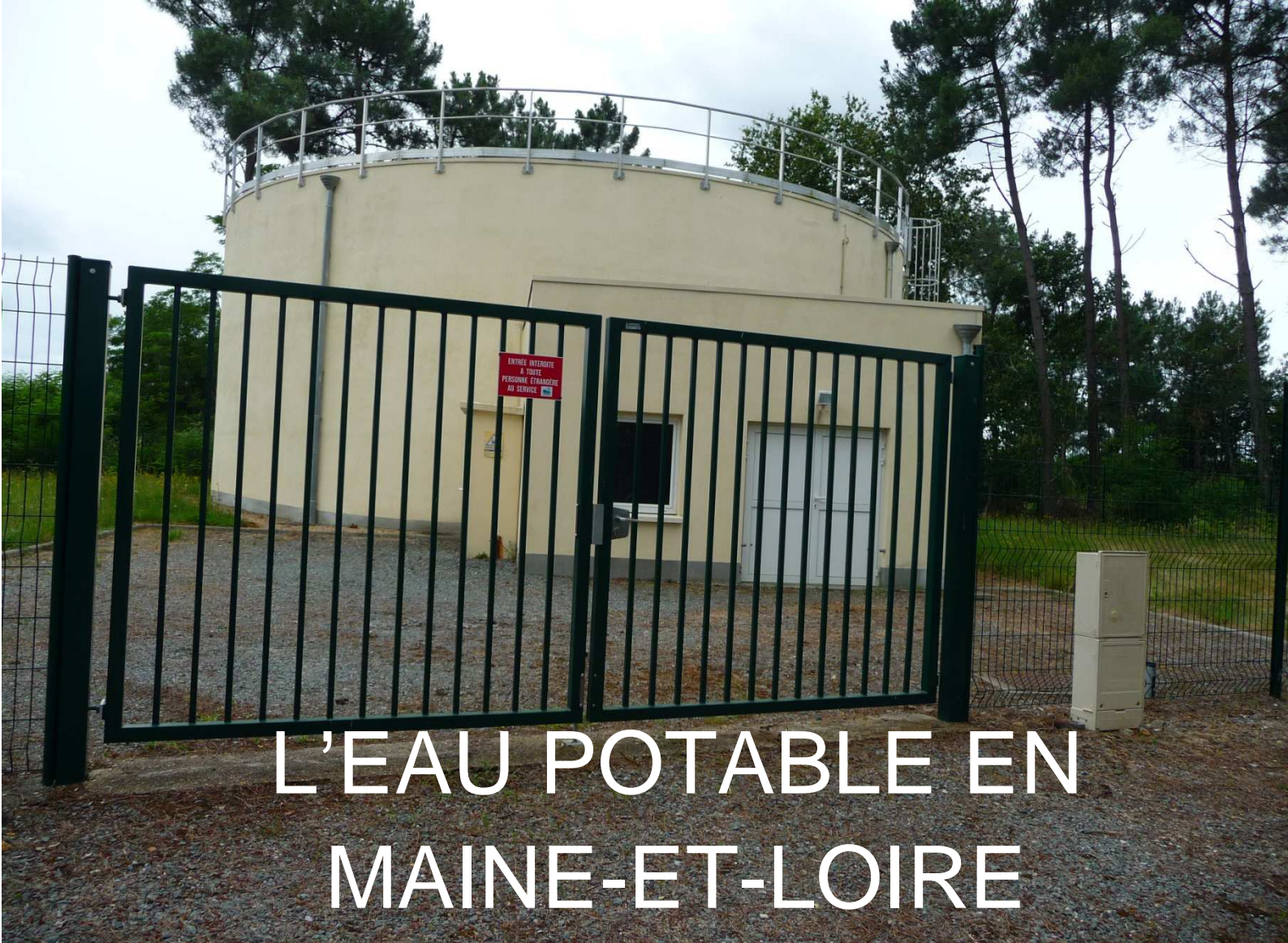
Réservoir de Bauné (Maine-et-Loire)
